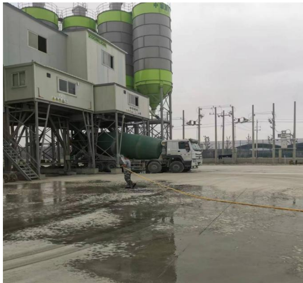
运输扬尘洒水及筒仓除尘
