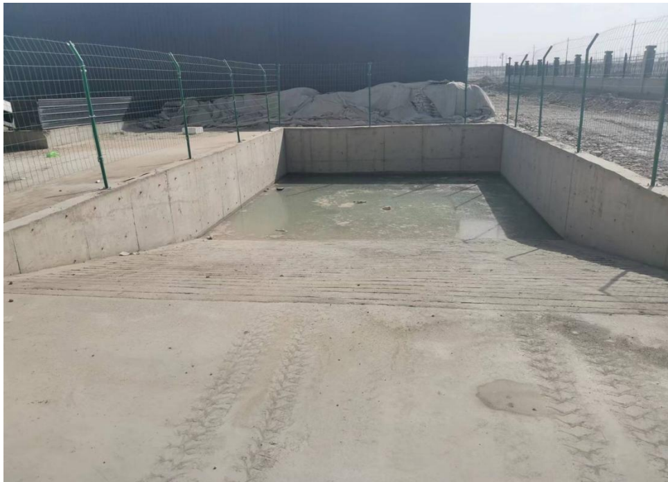
图 3-2 100m 3 生产废水沉淀收集池
