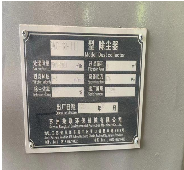
搅拌机脉冲反吹袋式除尘器
